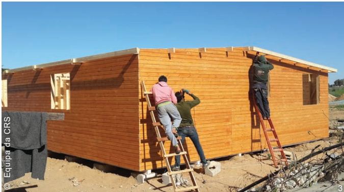
Foram construídas casas com estruturas de madeira numa plataforma com chão em contraplacado. Da esquerda para a direita, parte superior: 1. Colocação dos alicerces e vigas para o abrigo de transição. 2. Instalação de capa de contraplacado nas vigas do chão. Em baixo: 3. Fixação do revestimento externo da parede com parafusos. 4. Trabalhadores do empreiteiro a colocarem telhados de chapa ondulada de ferro galvanizado no abrigo.
