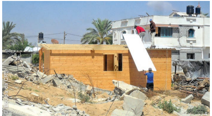
Foram construídas casas com estruturas de madeira numa plataforma com chão em contraplacado. Da esquerda para a direita, parte superior: 1. Colocação dos alicerces e vigas para o abrigo de transição. 2. Instalação de capa de contraplacado nas vigas do chão. Em baixo: 3. Fixação do revestimento externo da parede com parafusos. 4. Trabalhadores do empreiteiro a colocarem telhados de chapa ondulada de ferro galvanizado no abrigo.
