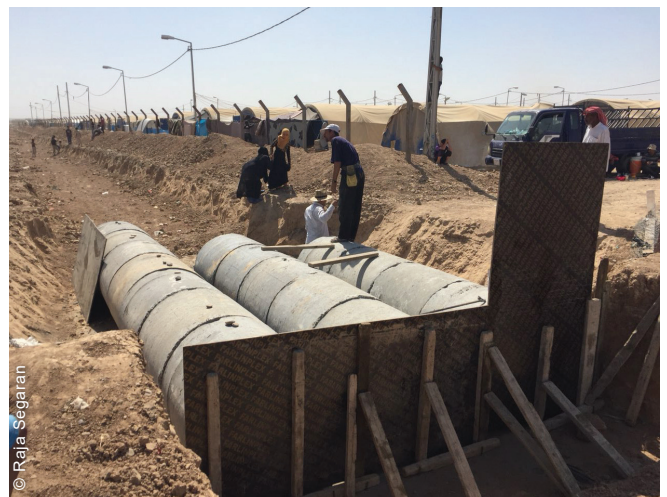
L'un des sites était vulnérable aux fortes pluies et a subi des inondations mineures pendant l'hiver. En 2018, les canaux de drainage des eaux pluviales et les ponceaux ont été modernisés.
