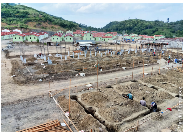
La construction des logements a été réalisée par des entreprises locales soumises à la supervision et au contrôle qualité de l'équipe de construction de l'organisation.
