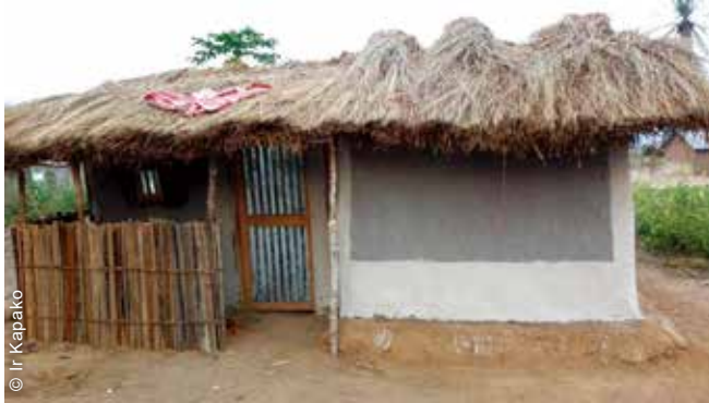
Les communautés ont participé activement au processus de conception. Grâce à leurs contributions, la superficie des abris a été étendue et une terrasse couverte ombragée a été ajoutée.
