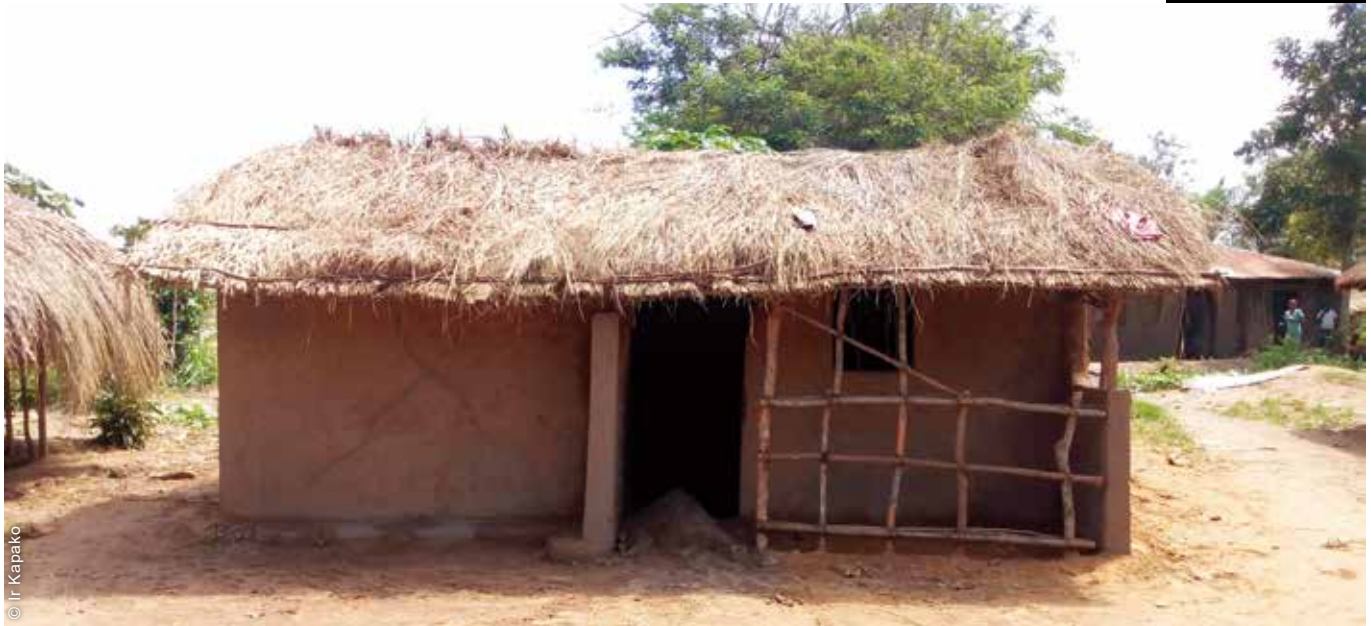
Les abris ont présenté un bon rapport qualité/prix, car les matériaux étaient disponibles localement et la main-d'œuvre a été fournie par les familles concernées.
