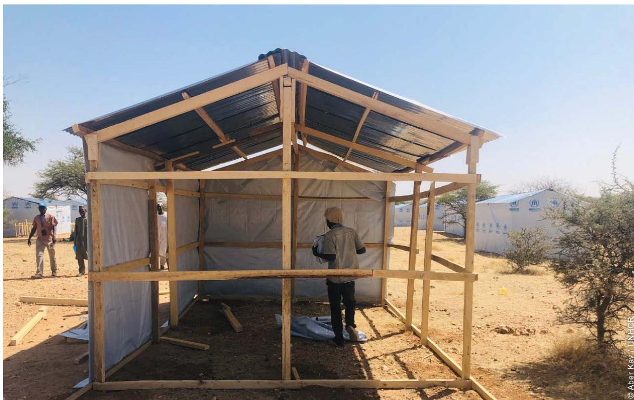
Des abris familiaux temporaires ont été construits pour chaque ménage de réfugiés arrivant dans le nouvel établissement, dans l'idée que ceux-ci puissent ultérieurement renforcer les murs à l'aide de matériaux plus solides et disponibles localement (clayonnage enduit de torchis, par exemple).
