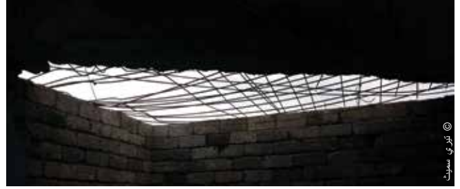
أعاد المشروع ترميم المنازل من خلال مخطط القسام. وشملت أعمال الإصلاح الأسقف والجدران.
