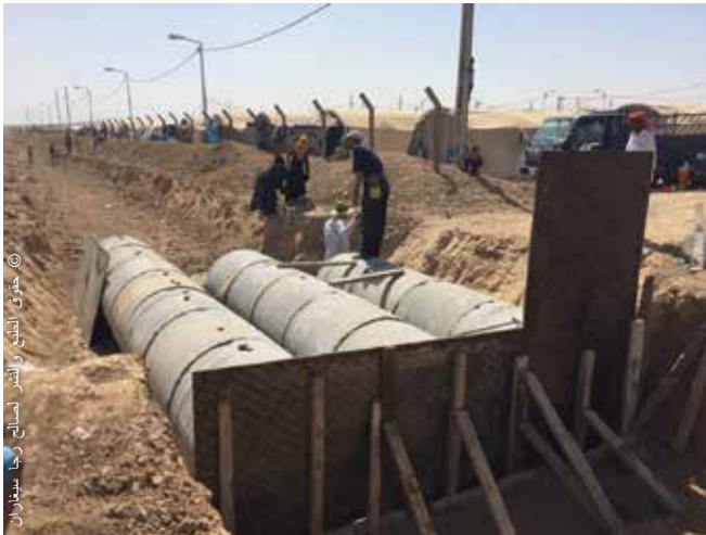
تعرّض أحد المواقع للأمطار الغزيرة وحدثت فيه فيضانات طفيفة في خلال فصل الشتاء. في عام 2018، خُصِّنت قنوات صرف مياه العواصف وقنوات المجاري.
