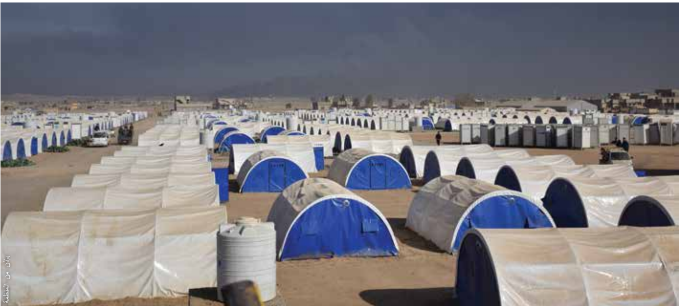
نُصِّبت خيامٍ قياسية حسب معايير الحكومة بمقاس 6 \times 4 م في المربعات المُجمَّعة التي يحتوي كلٌّ منها على 20 خيمة. كانت المساحة المخصصة للتوسُّعات قليلة جداً، لكن بعد انتقال الأسر، أُجريت تحسينات على أرض الواقع وركِّبت مرافق الكهرباء. يمكن للشركاء بعد ذلك بناء مرافق الخدمات في مربعاتٍ محددة مخصصة مسبقاً في خطة الموقع.
